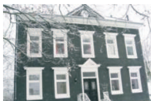
Altes Amt Sanitär und Heizungsinstallation
